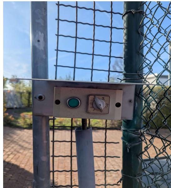
Einfach per Drehschalter den gewünschten Platz wählen und den grünen Knopf einmal drücken – zum Ausschalten einfach den Drehschalter auf „0“ stellen (ansonsten geht die Anlage durch Zeitschaltuhr autom. aus).
